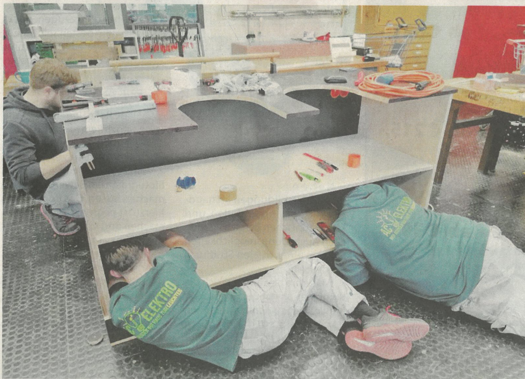
Voller Körpereinsatz bei der Elektroinstallation.
