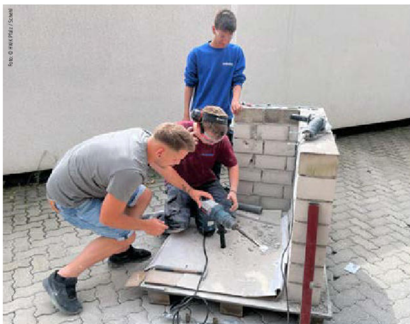
Im Grundkurs lernen die angehenden Auszubildenden im SHK-Handwerk erste grundlegende Werkzeuge und Tätigkeiten kennen (hier: Foto aus dem Grundkurs 2022).
